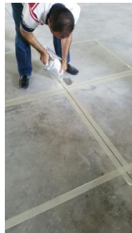
POUR INTO THE JOINT
